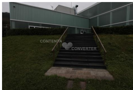
Escaleras desde campa a fachada trasera
