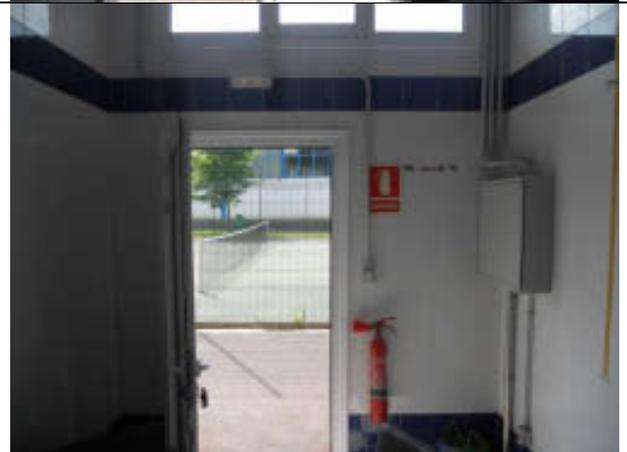
→ **Esquema Extintor:** aparato que contiene un agente extintor que puede ser proyectado y dirigido sobre un fuego por la acción de una presión interna.
