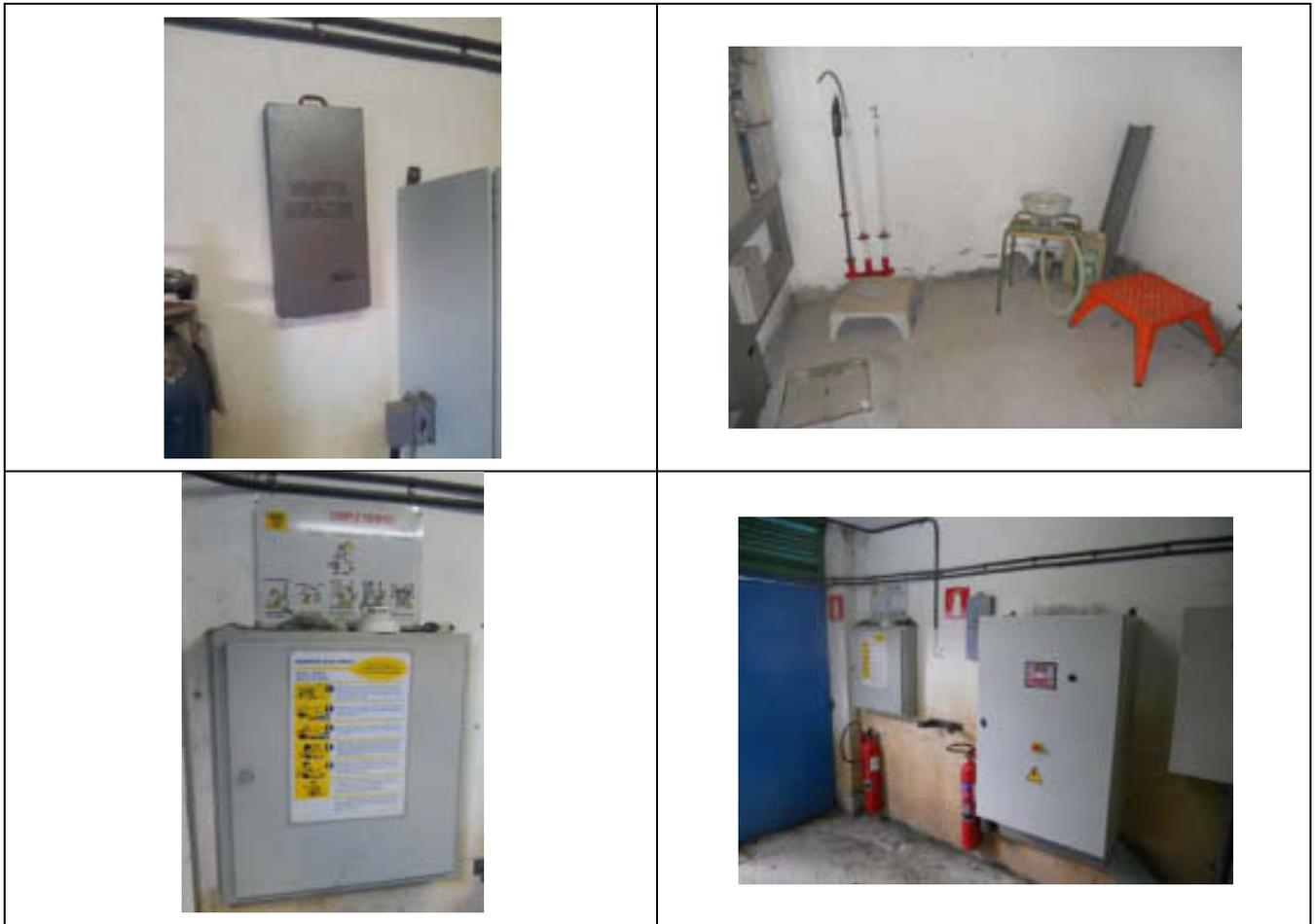
En la recepción donde está ubicado el cuadro eléctrico hay un extintor de 5 kg de CO<sub>2</sub> con una eficacia de 89 B, el extintor se encuentra colgado y señalizado, como se puede observar en la imagen.
