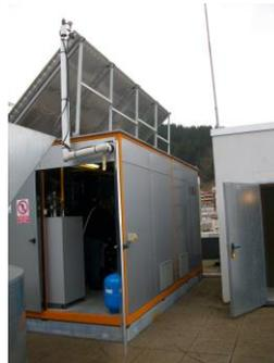
La calefacción de los locales de administración y reuniones se realiza mediante sistema de climatización ubicado en la cubierta del edificio.
