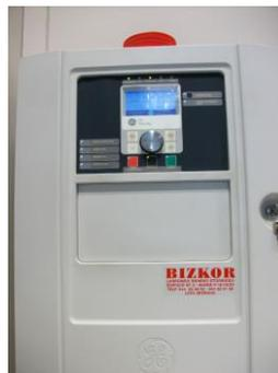
**Central de intrusión:** Consta de un sistema de detección de intrusión mediante detectores volumétricos y contacto magnéticos en puertas.
