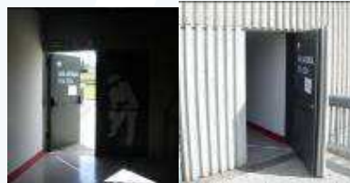
Salida SE2 (interior y exterior)
