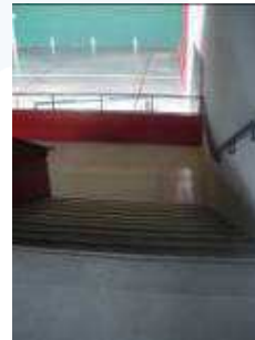
Escalera de interior Conexión Planta baja y 1ª E1
